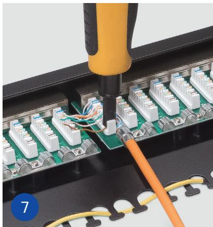
При помощи ударного инструмента производим заделку проводников в IDC контакты.
